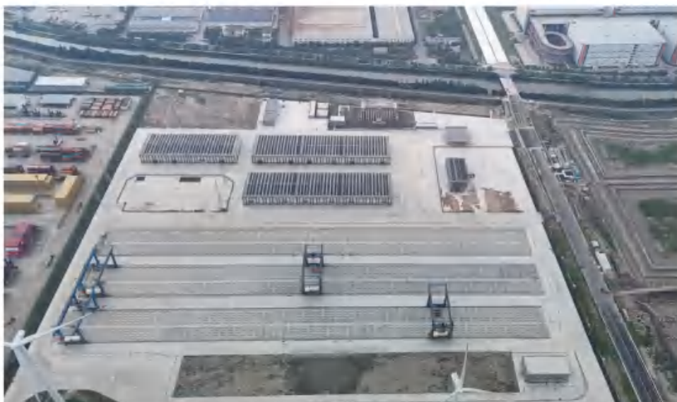
图 2.1-1 营运期后方陆域照片（拍摄时间：2025 年）
