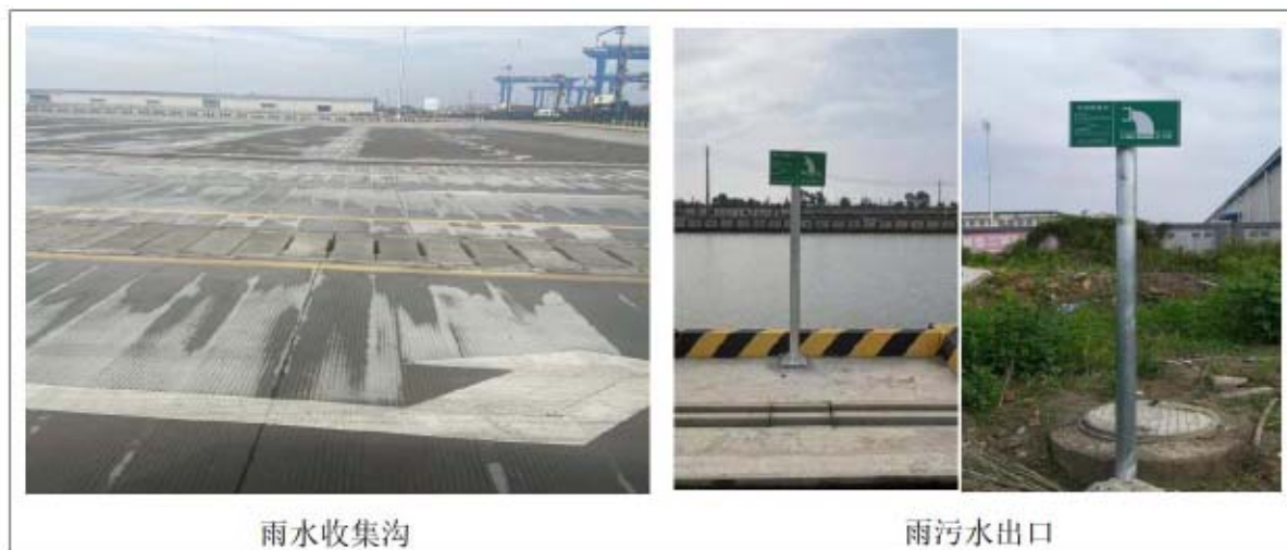
图 6.1-2 其他雨污水收集处理设置图
