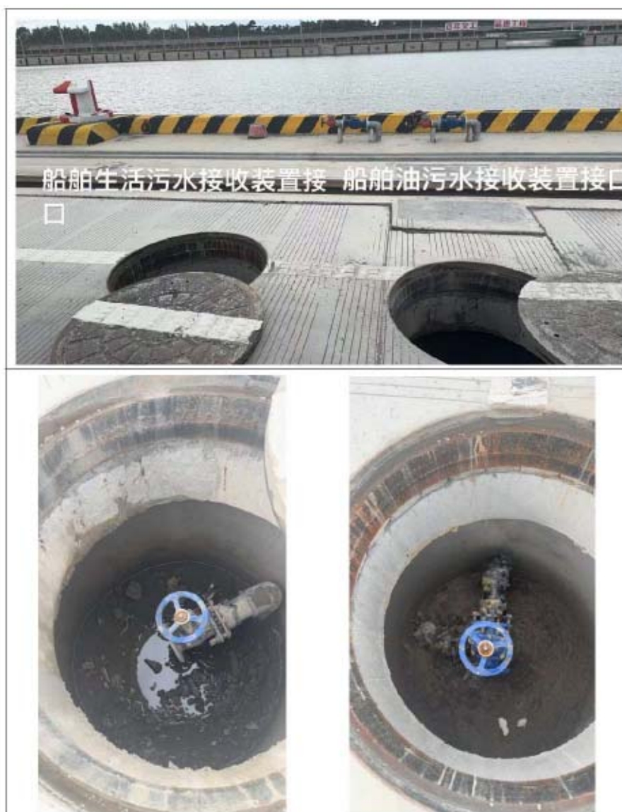
图 6.1-1 船舶油污水及船舶生活污水接收装置图
