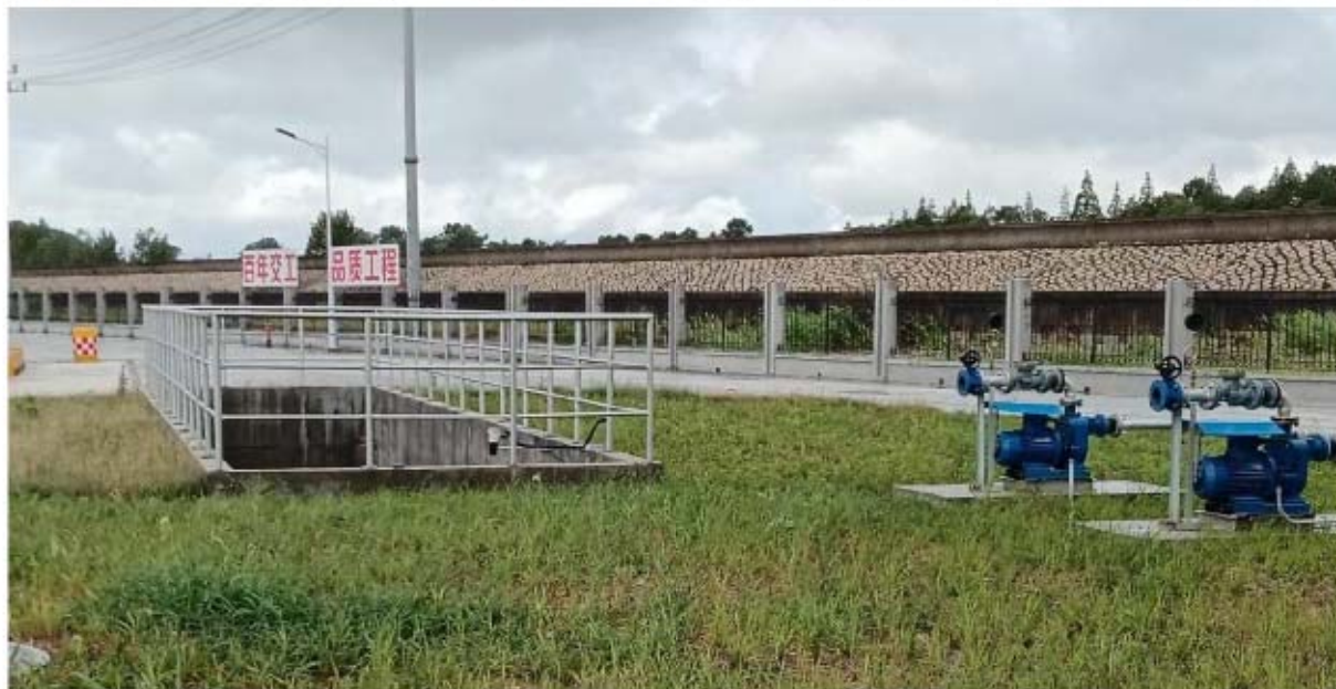
图 11.3-3 事故应急池（地下）照片
