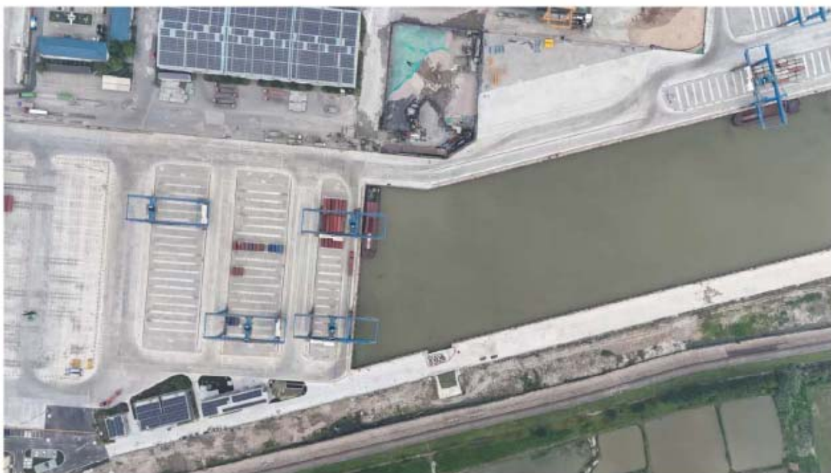
图 2.2-1a 试运行期航拍图
