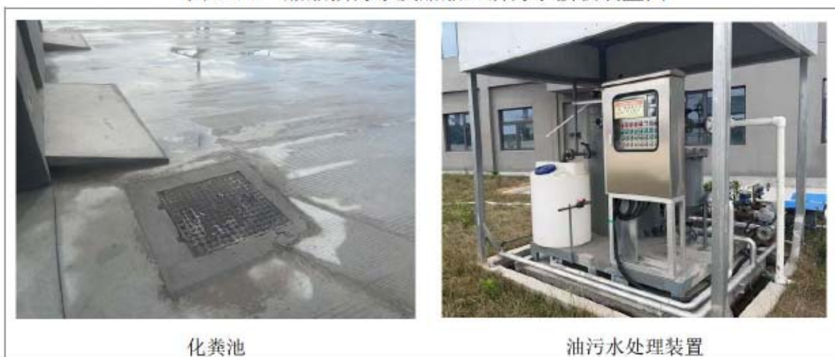
图 6.1-1 船舶油污水及船舶生活污水接收装置图
