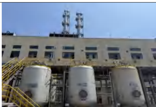
储罐接入废气管道
