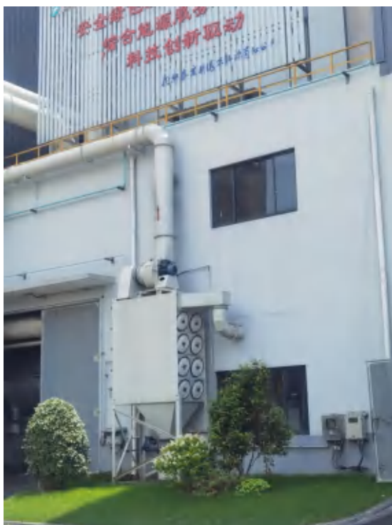
胶粒破包废气布袋除尘器
