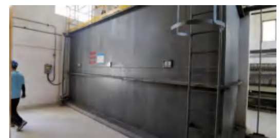
脱硫废水处理设施（依托）
