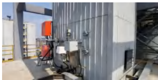
4#炉烟气在线监测系统（依托）
