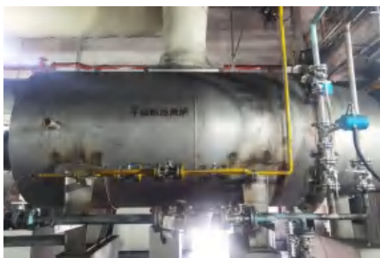
干燥机热风炉
