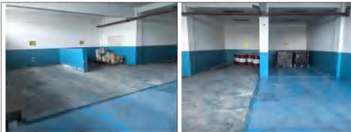
图 2.5-9 厂区内现有危废暂存场所照片
