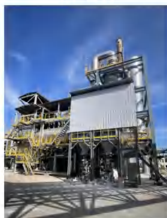
改造内容现场全貌
