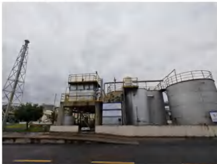
图 4.1-2 厂区污水处理站照片
