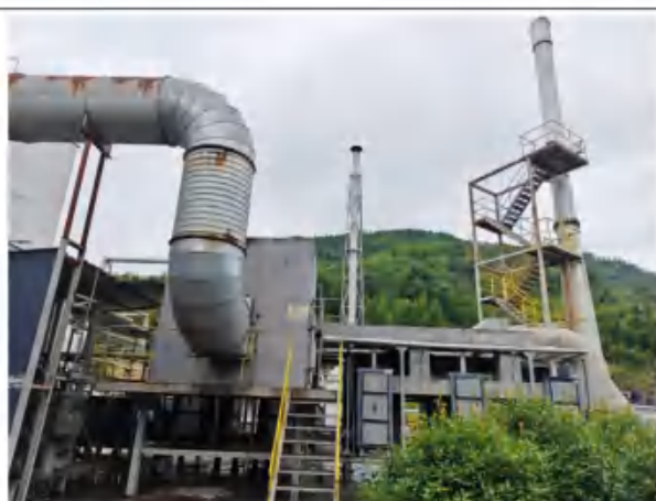
聚氨酯低浓废气活性炭吸附-脱附焚烧装置
