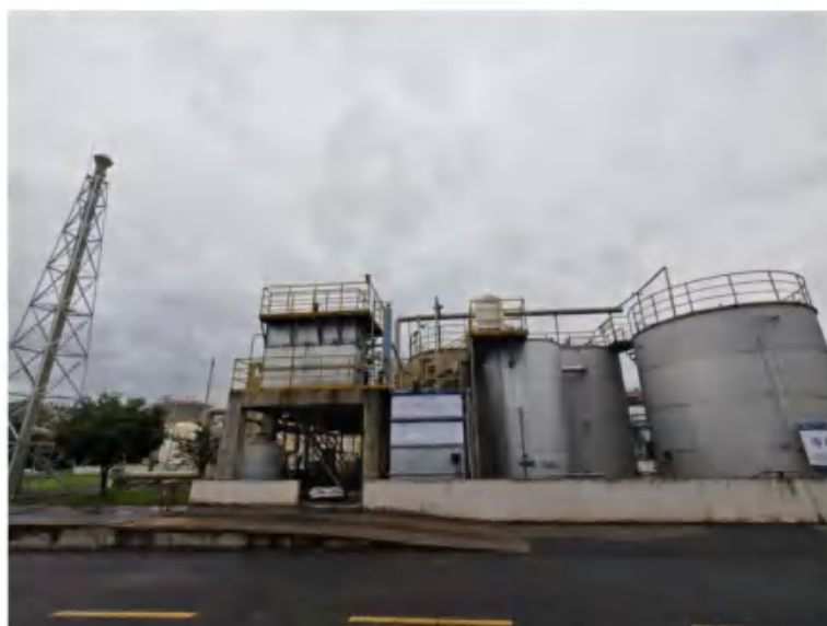
图 4.1-2 厂区污水处理站照片
